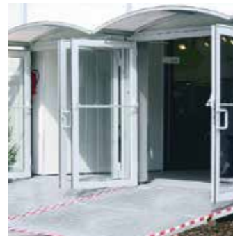
Aluminium-Tür 2-flügelig mit Vordach und langer Rampe
